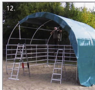
12. Die Folie wird nun an den Abspannrohren über die Dachkonstruktion gezogen.
