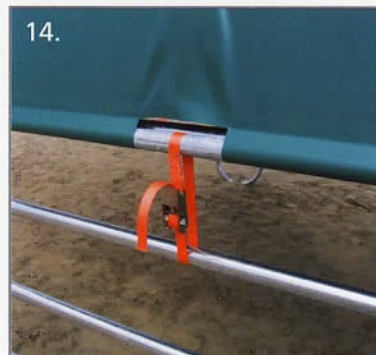
14. Die Gurtspanner werden nun mit dem Abspannrohr und der Waagerechten des Elementes verbunden und gleichmäßig angezogen.
