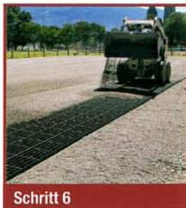
Schritt 6 Verfüllung der Fläche
